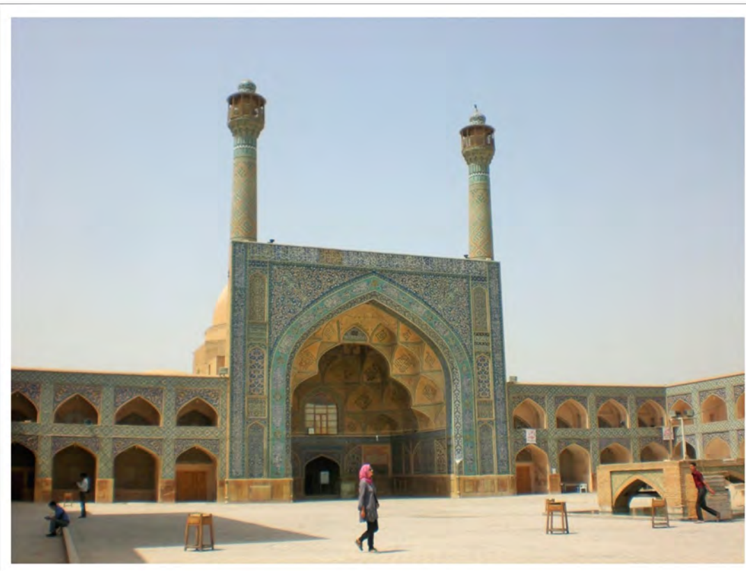
Iszfaháni Péntek-mecset Iszfahán, 1088–1121
